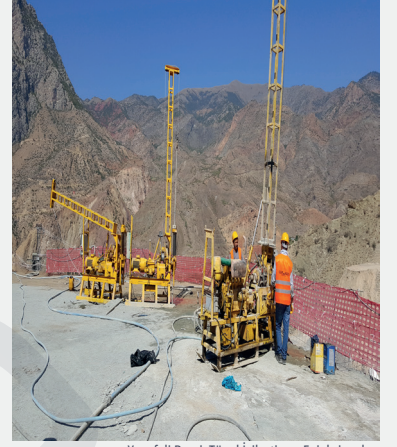
Yusufeli Barajı Tünel İyileştirme Enjeksiyonları
