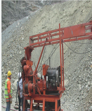
Yol ve Tünel Araştırma Sondajları
