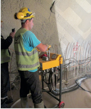
Tünel Delgi Çalışmaları
