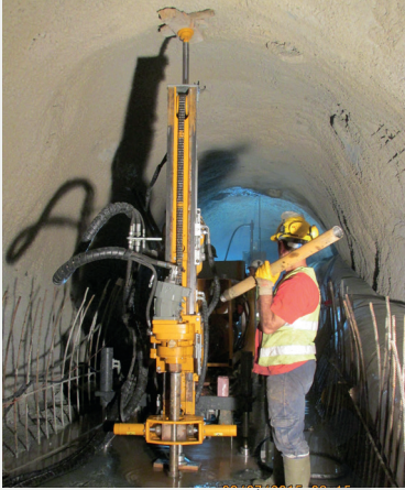
Yusufeli Barajı Tünel iyileştirme Enjeksiyonları
