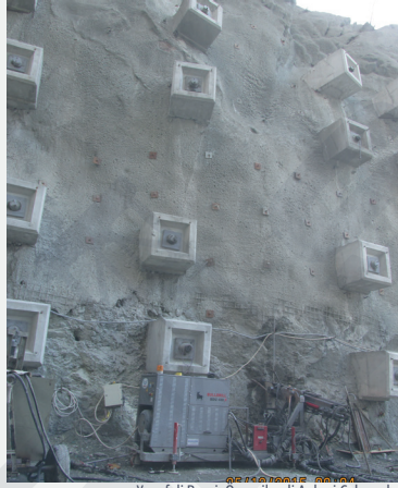
Yusufeli Barajı Öngerilmeli Ankraj Çalışmaları
