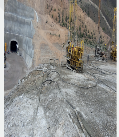
Tünel Delgi ve Enjeksiyon Çalışmaları
