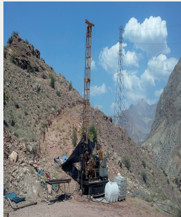
Zemin Etüdü Çalışmaları
