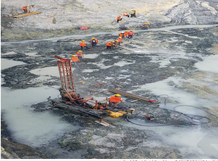
Yusufeli Barajı Kontak Konsolidasyon Delgi ve Enjeksiyon Çalışmaları
