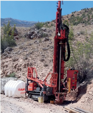
Zemin Etüdü Çalışmaları
