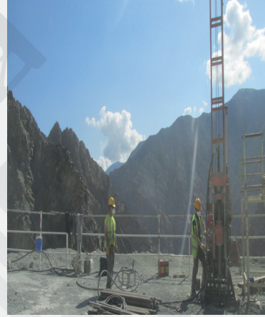
Konsolidasyon Enjeksiyonu Çalışmaları
