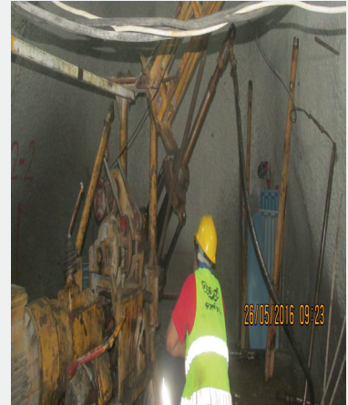
Tünel Kontak ve Konsolidasyon Enjeksiyonu Çalışmaları
