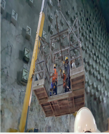
Yusufeli Barajı Öngerilmeli Ankraj Çalışmaları
