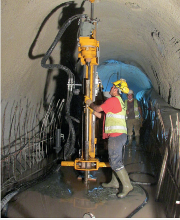
Yusufeli Barajı Delgi Enjeksiyon Çalışmaları
