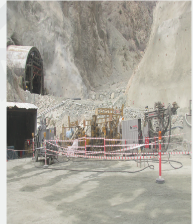
Tünel Sondaj ve Enjeksiyon Çalışmaları
