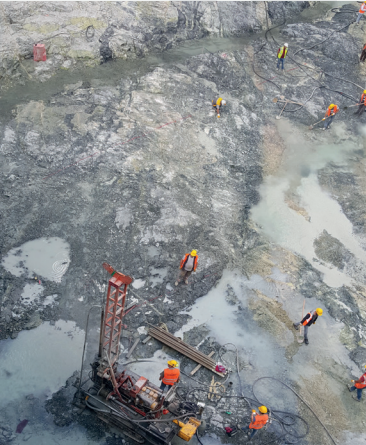
Yusufeli Barajı Kontak Konsolidasyon Enjeksiyonu Çalışmaları
